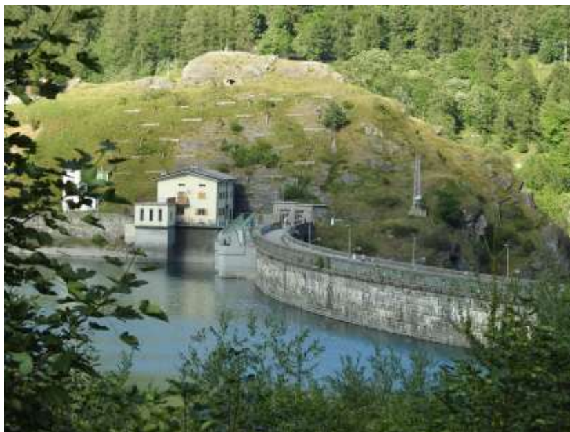
Diga di Pontechianale nella frazione Castello - Foto di Luca Grande e Simona Pons
